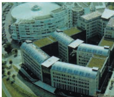
Hotelcomplex, Spreebogen, Berlijn
