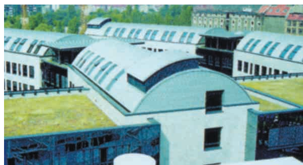
Hotelcomplex, Spreebogen, Berlijn
