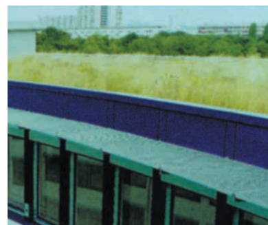
Bureaucentrum Garbe, Stuttgart
