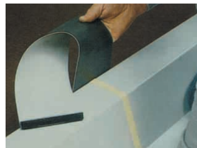
Pvc-gecacheerde staalplaat stootverbinding (afdekken met dakdichtingsbaanstrook)
